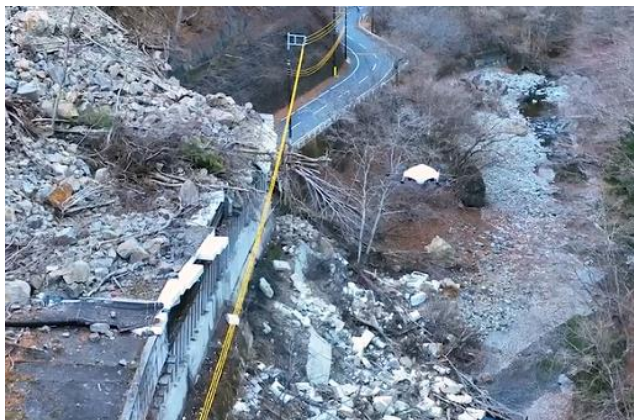
《図表6》 土砂崩れ現場を越えるドローン（中央白色）
