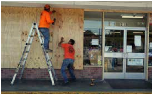
ハリケーン・ドリアンの上陸に備え、窓にベニヤ板を打ち付ける作業員。フロリダ州デルレイ・ビーチ。
